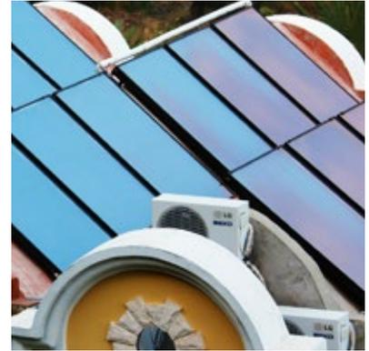
Paneles solares térmicos son equipos que utilizan la radiación solar para calentar el agua, la cual es posteriormente almacenada en contenedores. Estos equipos necesitan de un sistema de respaldo, ya que dependen de la radiación disponible para el calentamiento de agua. Suelen utilizarse también como sistemas de precalentamiento o calentadores en paralelo a una caldera.
